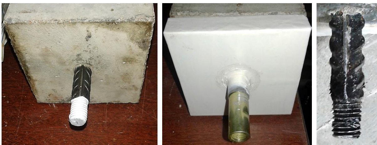
Figure 2-14. Mise en œuvre de la protection des armatures longitudinales hors du béton. Etat du filetage après 452 jours d'immersion.
