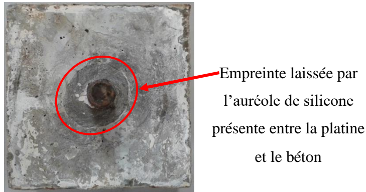
Figure 3-16. Empreintes laissées par le silicone ayant partiellement comblé le jeu initial entre les platines et le béton des corps d'épreuves.
