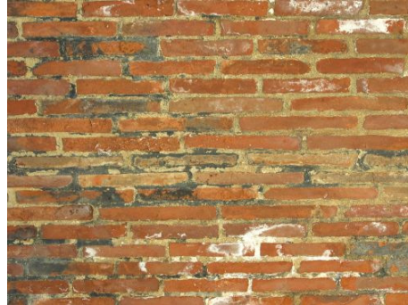
Figure 30 - Détail des maçonneries de briques. Photo N. D.
