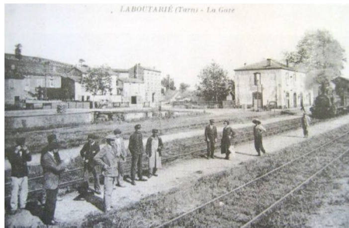
Figure 22 – La gare de Laboutarié vers 1900. D'après VIEU Bernard, dans Connaissance du rail n°70, sept. 1986, p.10.
