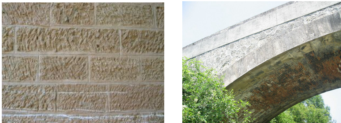
Figure 31 - A droite : PS de la Millette, murs en maçonnerie de moellons à joints incertains (opus incertum), bandeau en pierre de taille, corps de voûte en briques. A gauche : Pont de Montsalvy, détail de maçonnerie à moellons smillés à assise horizontale.
