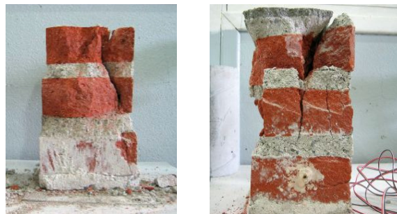
Figure 49 - Essais sur sandwiches. Photos après rupture.
