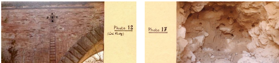
Figure 37 - Photos de l' Inspection du viaduc de Taillefer, Rapport du contrôleur. SNCF, région de Toulouse, 26 novembre 1973.
