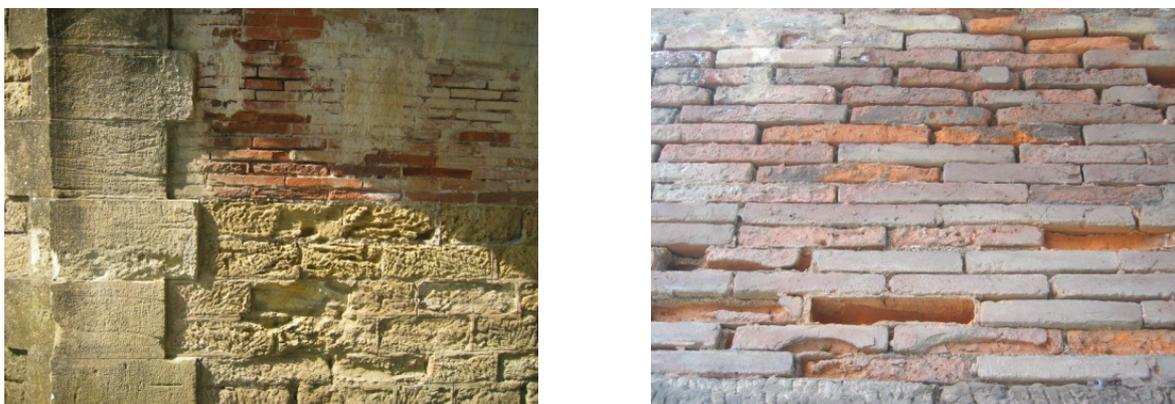
Figure 35 - Altération des briques, des pierres de taille et des moellons. Photos N.D.
