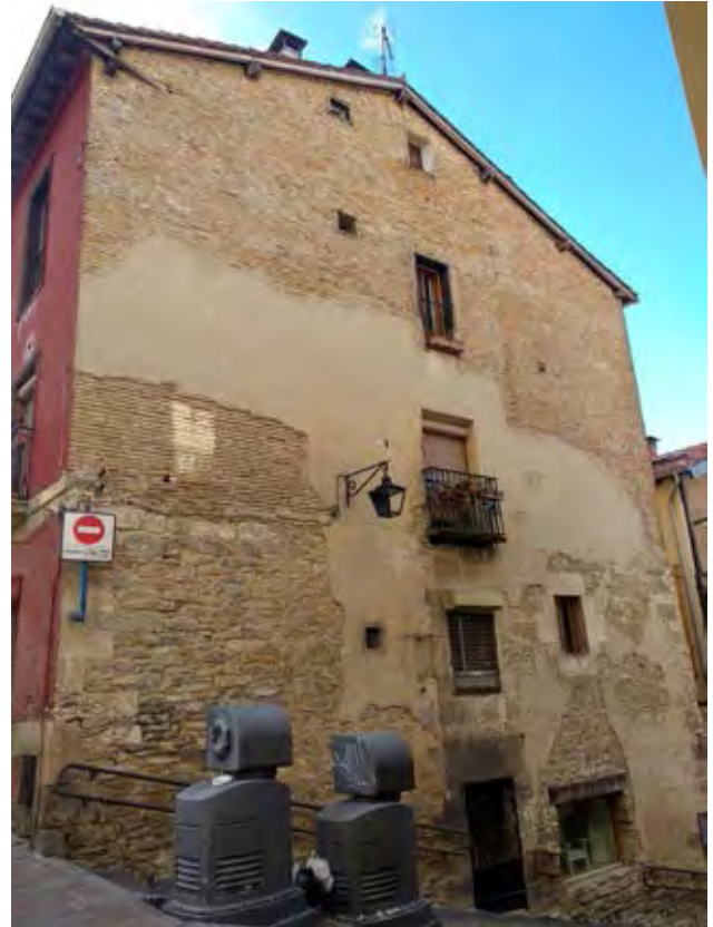
Façade nord-ouest en granit et briques.
