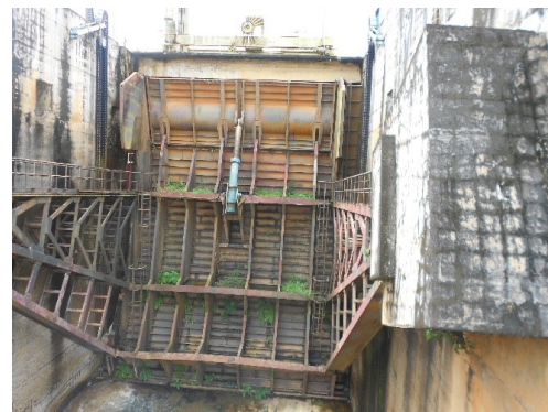
Fig. 7 : Photo de l'évacuateur de crues de Song Loulou
