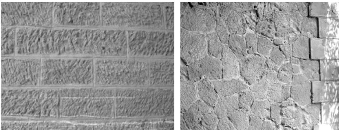
Figure 11. – (a) Pont de Montsalvy, détail de maçonnerie à moellons *smillés* à assise horizontale. (b) Pont du Leingary, murs en maçonnerie de moellons à joints incertains (*opus incertum*) et chaînage en pierre de taille.
