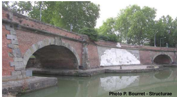
Ponts Jumeaux en maçonnerie (1770-1775)
