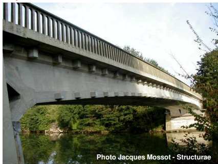
Pont de Luzancy – Seine et Marne (1940-1946) – portée = 55 m
