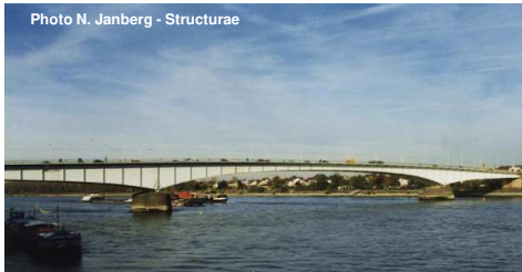
Pont Kennedy – Allemagne (1949) – portée = 196 m
