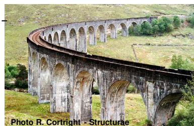
Viaduc de Glenfinnan (1898) – portée de 15 m
