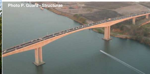
Pont de Sydney – Australie (1980-1986) – portée = 260 m
