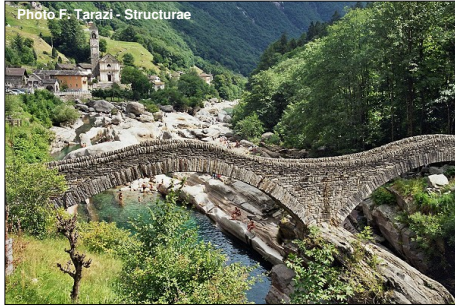
Passerelle sur la Verzasca (Suisse)
