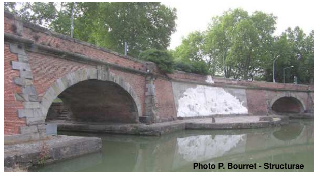
Ponts Jumeaux en maçonnerie (1770-1775)
