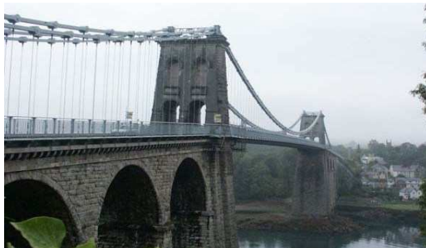
Pont du détroit de Ménai (Pays de Galles – 1826) – portée = 177 m
