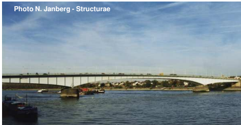
Pont Kennedy – Allemagne (1949) – portée = 196 m
